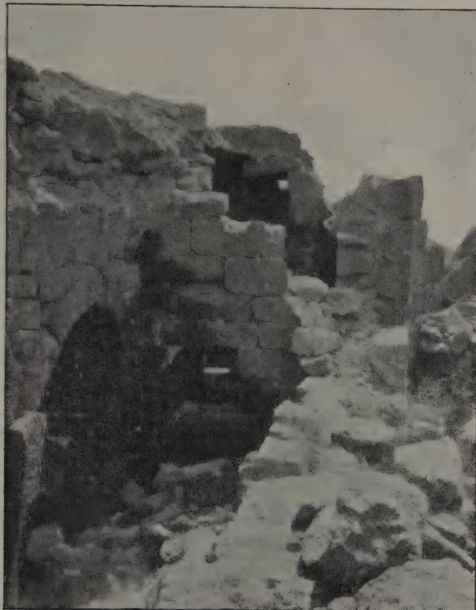
FIG. 220.—Maden Dagh, S. aisle, looking E.
